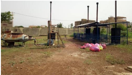
Figure 11 : Site de stockage/traitement des déchets Hôpital du Mali
