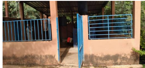
Figure 12 : Site de stockage/incinération Hôpital dermatologique de Bamako
