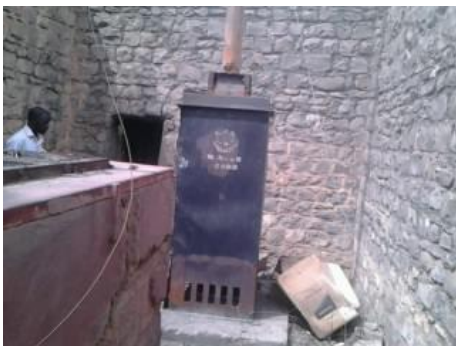
Figure 13 : Site Incinération/ CSRéf Kayes
